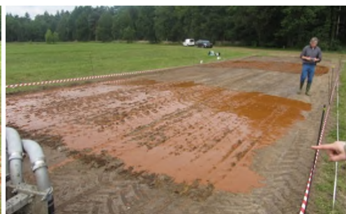
D. INJECTEREN IJZERSLIB NA ZODE VERWIJDERING
