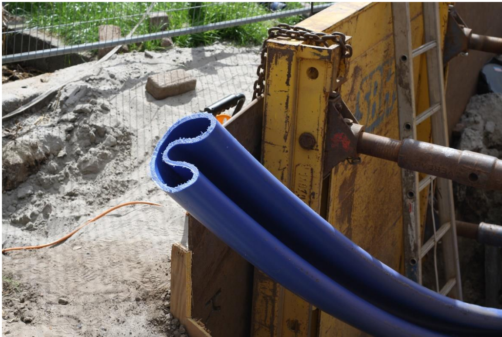
Figuur 2.2 Compact Pipe in gevouwen toestand, Zwaagwesteinde, 28 juni 2016.
