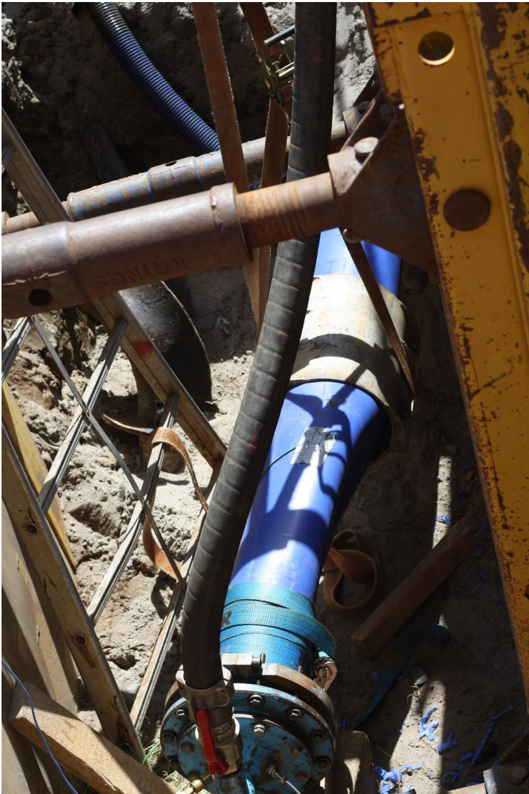
Figuur 3.4 Uitvouwen d.m.v. stoom, foto van uittredepunt.
